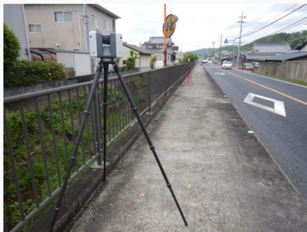
地上レーザー測量 観測状況
